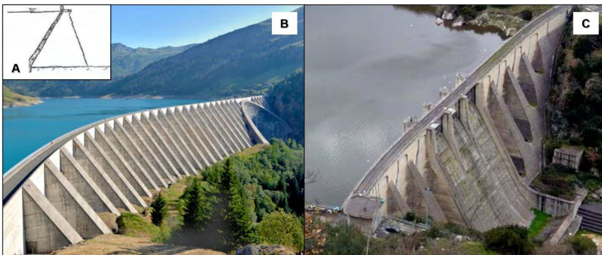
**Figura 5** – A) Esquema de contraforte; B) Barragem Roseland; C) Barragem Miranda do Douro. Modelo de A modificado de Costa (2012), fotos de B e C retirados de *Global Energy Observatory* (2012).
