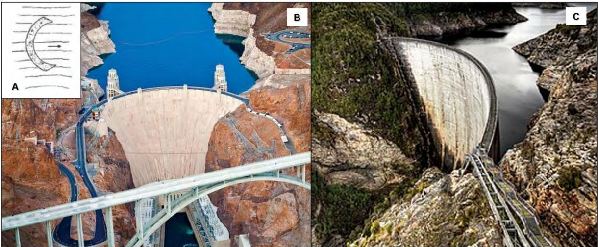
**Figura 4** - A) Esquema da estrutura em arco; B) Barragem Hoover; C) Barragem Gordon. Modelo de A modificado de Costa (2012), fotos de B e C retirados de *Bureau of Reclamation* (2024) e *Institution of engineers* (2000).
