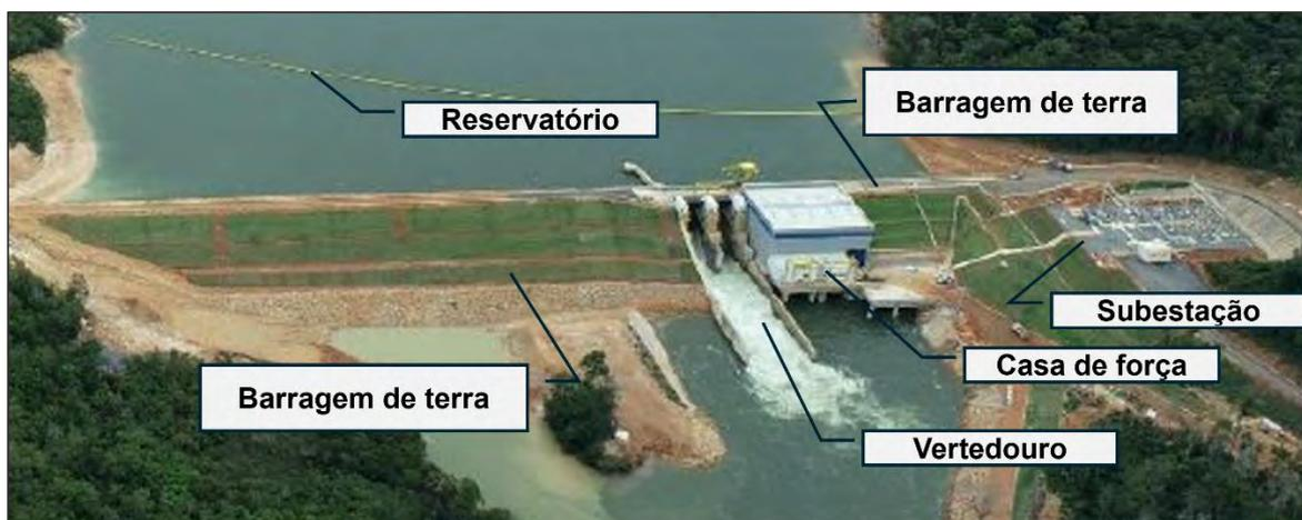
**Figura 23** - Representação das principais estruturas da barragem do modelo A. Modificado da base de dados da empresa.
