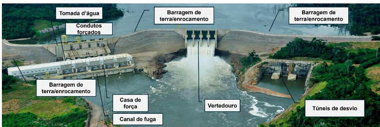
**Figura 16** - Representação da localização das principais estruturas da barragem do modelo A. Modificado da base de dados da empresa.
