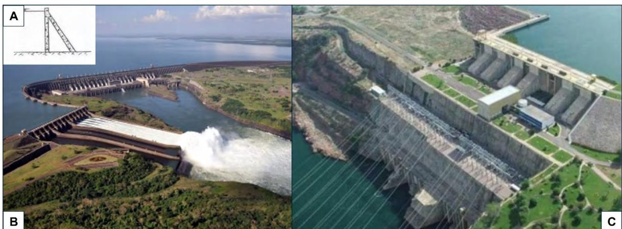
**Figura 3** - A) Esquema da estrutura concreto-gravidade aliviado; B) Barragem Itaipu; C) Barragem de Paulo Afonso IV. Modelo de A modificado de Costa (2012), fotos de B e C retirados de Itaipu Binacional (2024) e Eletrobras (2024).
