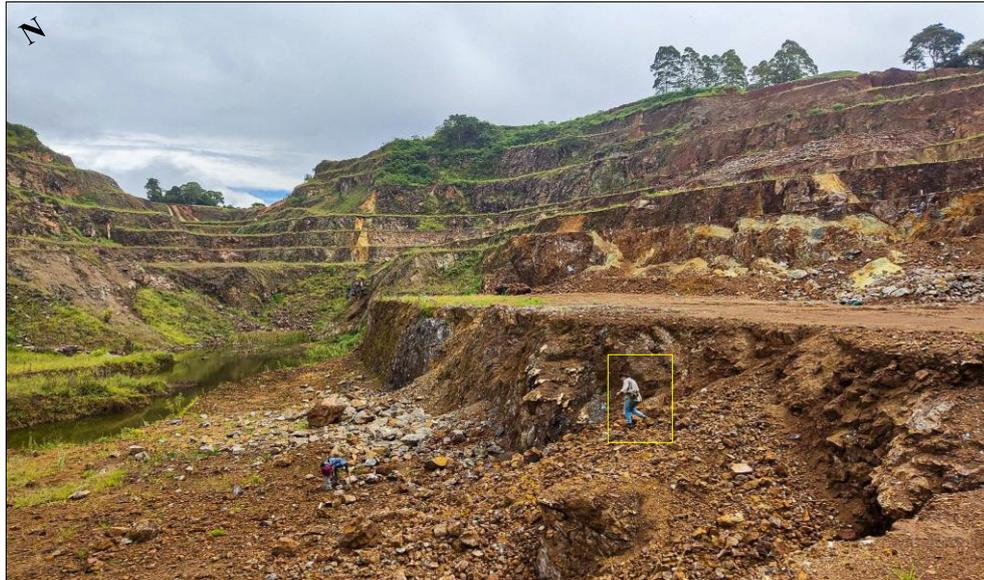
Figura 3 - Visão geral de uma das frentes de lavra com diversas bancadas da jazida de fluorita da Mineração Nossa Senhora do Carmo. O trabalho de amostragem foi concentrado nessas bancadas e nas pilhas de detonação, na base delas. Em destaque no polígono amarelo: pessoa com 1,65 m de escala na foto.
