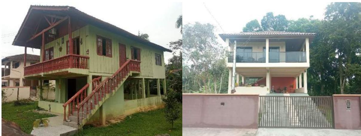
Figura 18: Exemplos de construções elevadas no Bairro Rocio.
