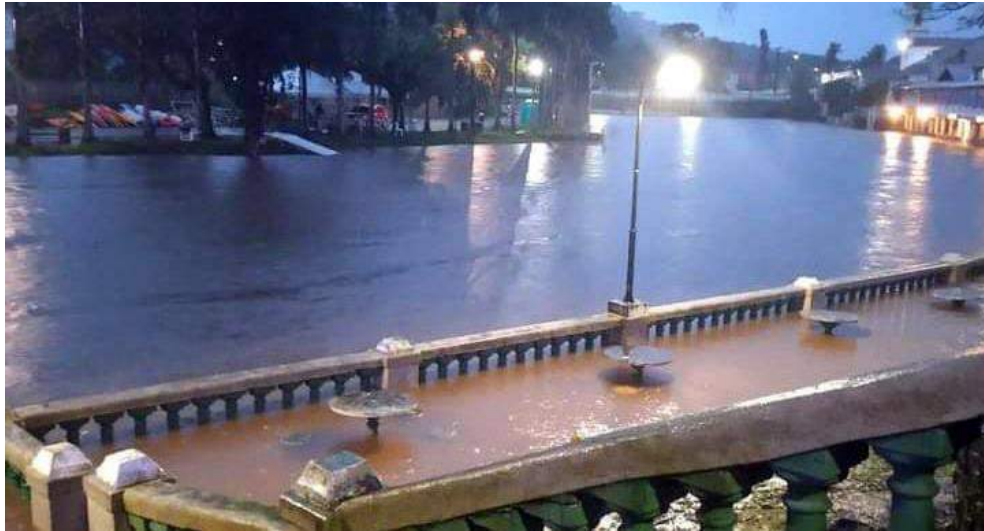
Figura 20: Rio Nhundiaquara em inundação 1 de novembro de 2021. (Imagem: Defesa Civil do Paraná)
