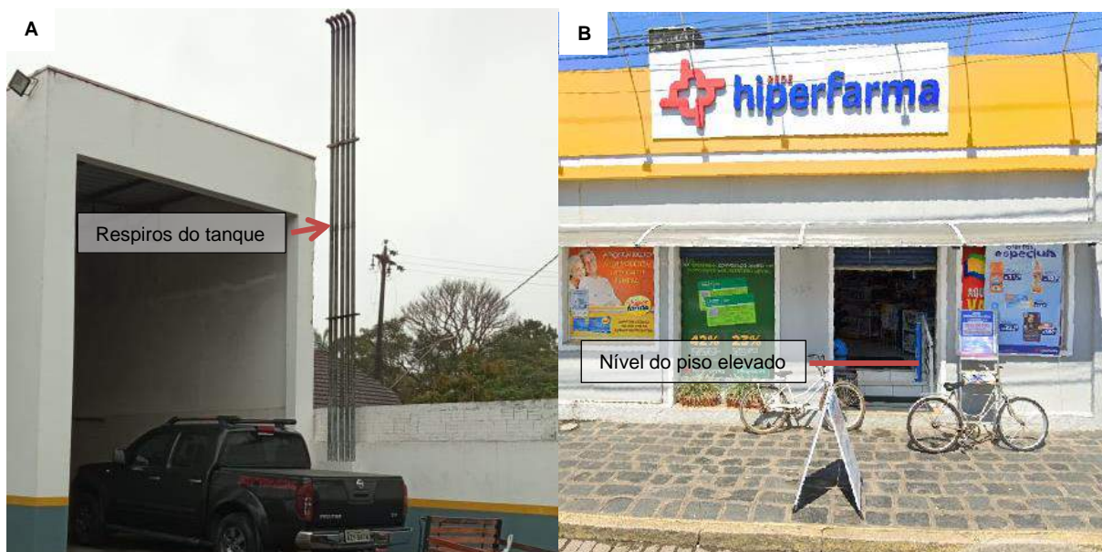
Figura 26: A) Respiro elevado de tanque de armazenamento em posto de combustível; B) Exemplo de entrada elevada em cerca de 0,5m, padrão para os comércios no centro.
