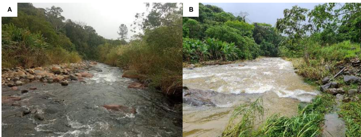
Figura 24: Rio do Pinto. A) Depósitos de seixos e blocos no Rio do Pinto; B) Dique artificial nas margens do Rio do Pinto após o evento de inundação de novembro de 2021 (Imagem B: Renato Lima, 2021).
