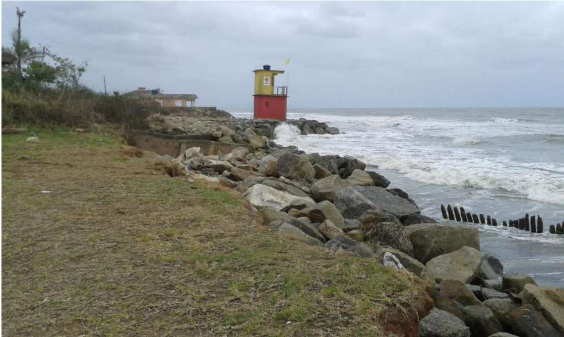
Figura 27 - Imagem mostrando o avanço da maré até os enrocamentos construídos neste local (fonte: Maria Cristina de Souza).
