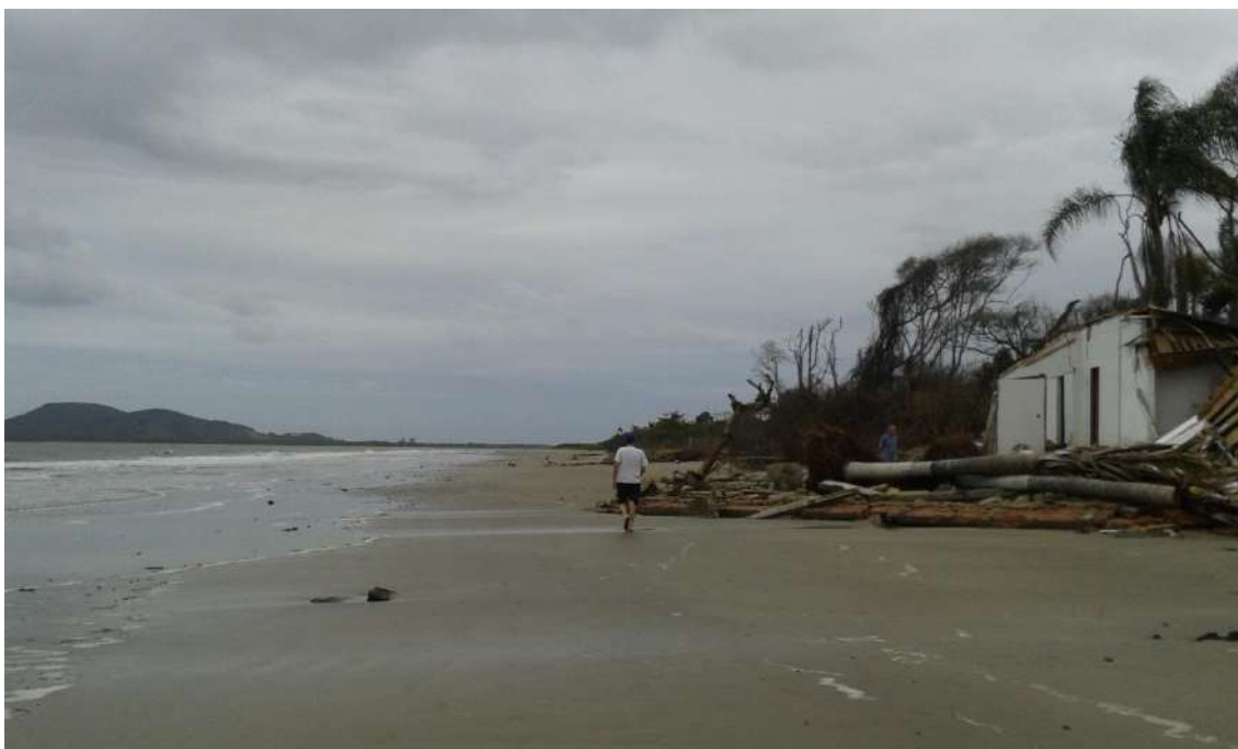
Figura 24 - Imagem ilustrando uma casa localizada próximo a região do Pontal, onde ocorreu grande erosão devido a ressaca de novembro de 2016 (fonte: Maria Cristina de Souza).
