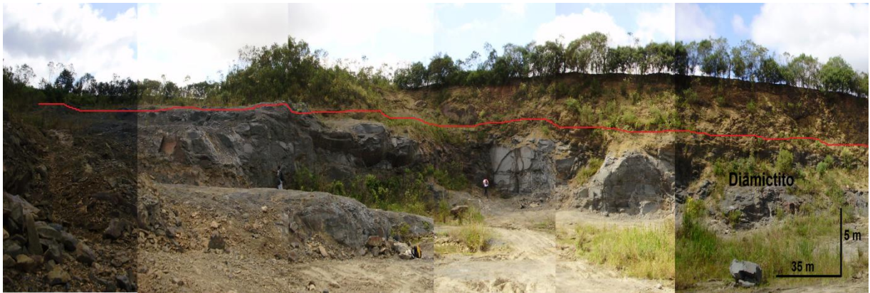
Figura 8- Vista da pedreira em Lapa –PR, com a camada de diamictitos.
