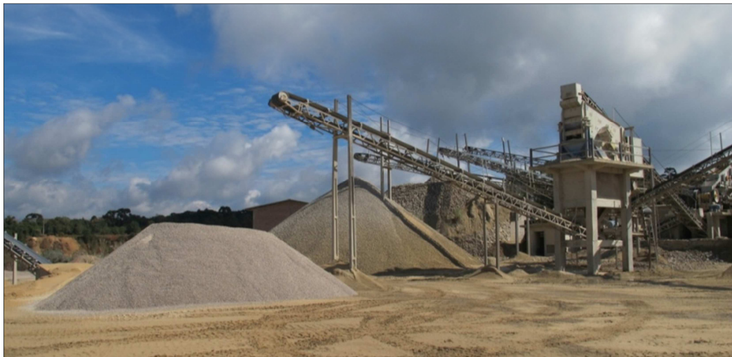
Figura 26. Britador e pilhas de material britado.
